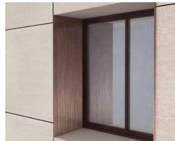
La versione con imbotte in lamiera marca maggiormente la presenza delle finestre. In questo caso, la scelta tecnica prevede una grande accuratezza nella realizzazione dei lamierati, che devono comprendere dei profili di compensazione per le dilatazioni e le tolleranze costruttive dell'edificio.
